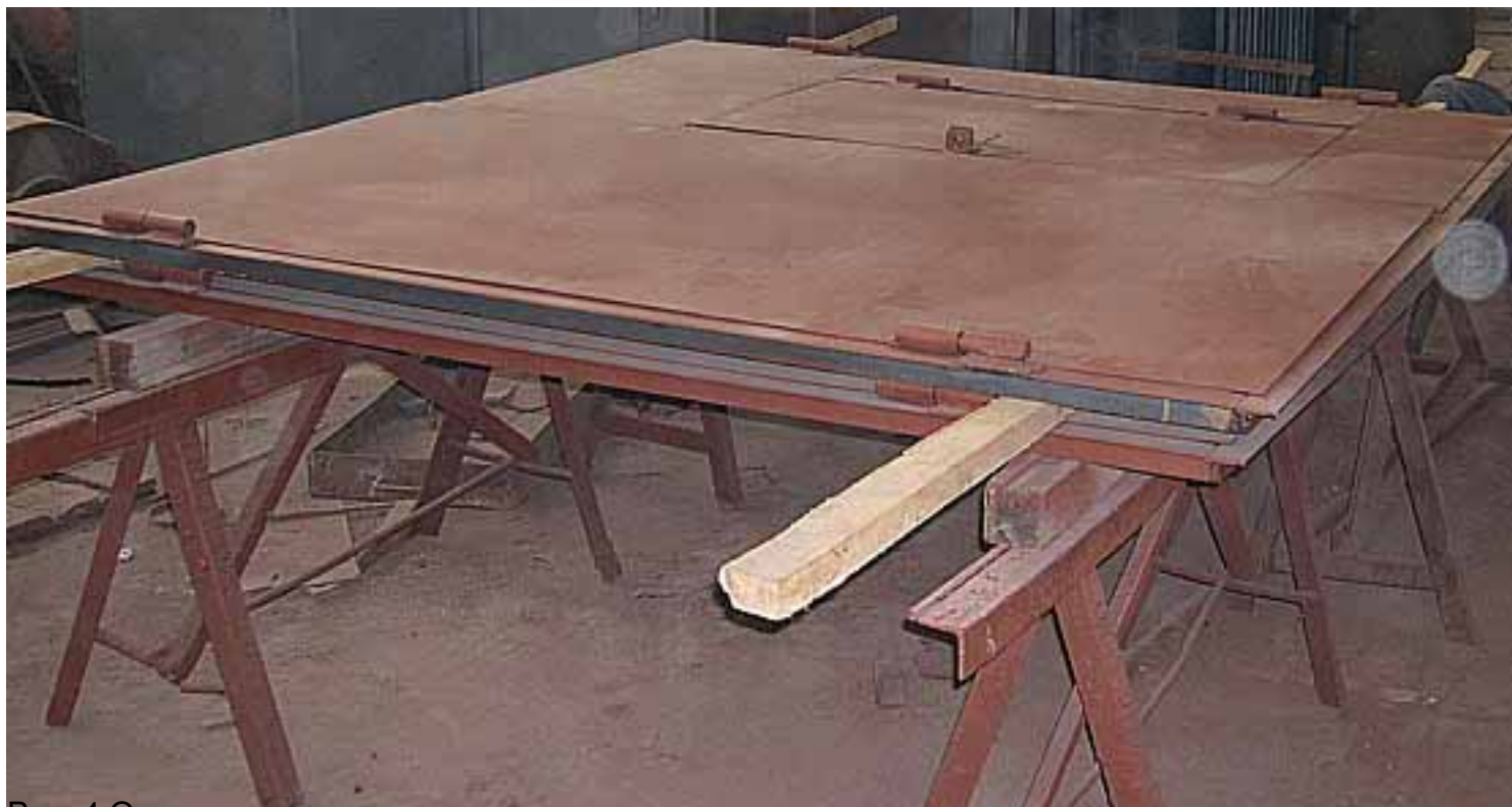
Рис. 4 Окраска гаражных ворот грунтом
